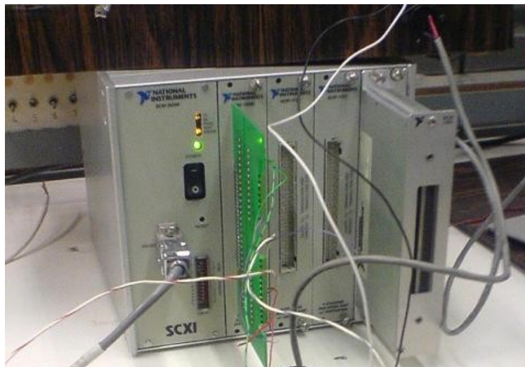
Figura 46 - Chassi SCXI e interligações
